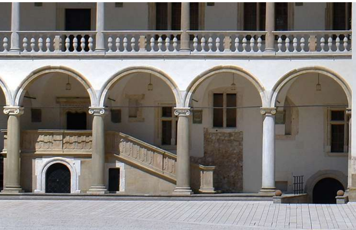
26. Widok na część piwnic z Sienią Tatarską – Zamek Królewski na Wawelu w Krakowie.
